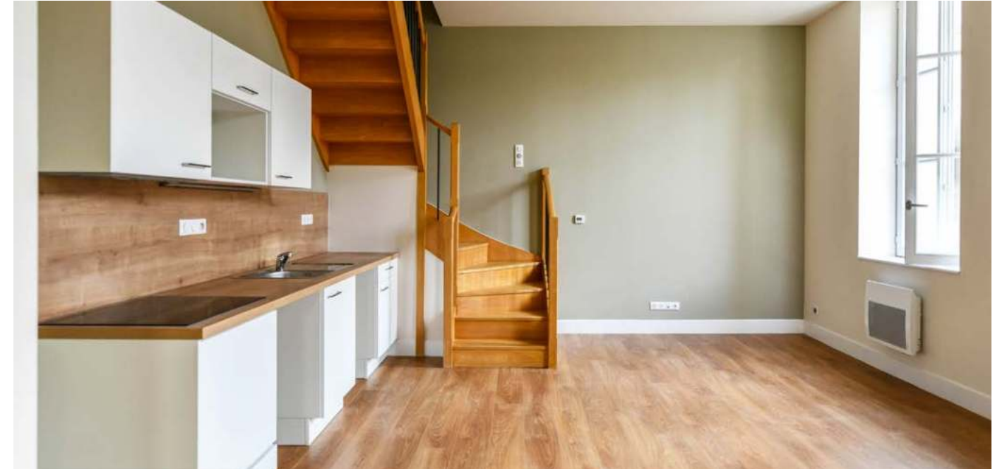
Création d'un escalier en bois massif dans un appartement en duplex.
