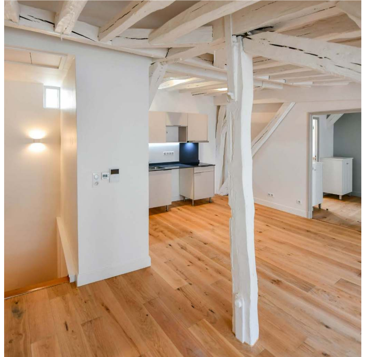
Restauration et mise en valeur des poutres d'origine.
