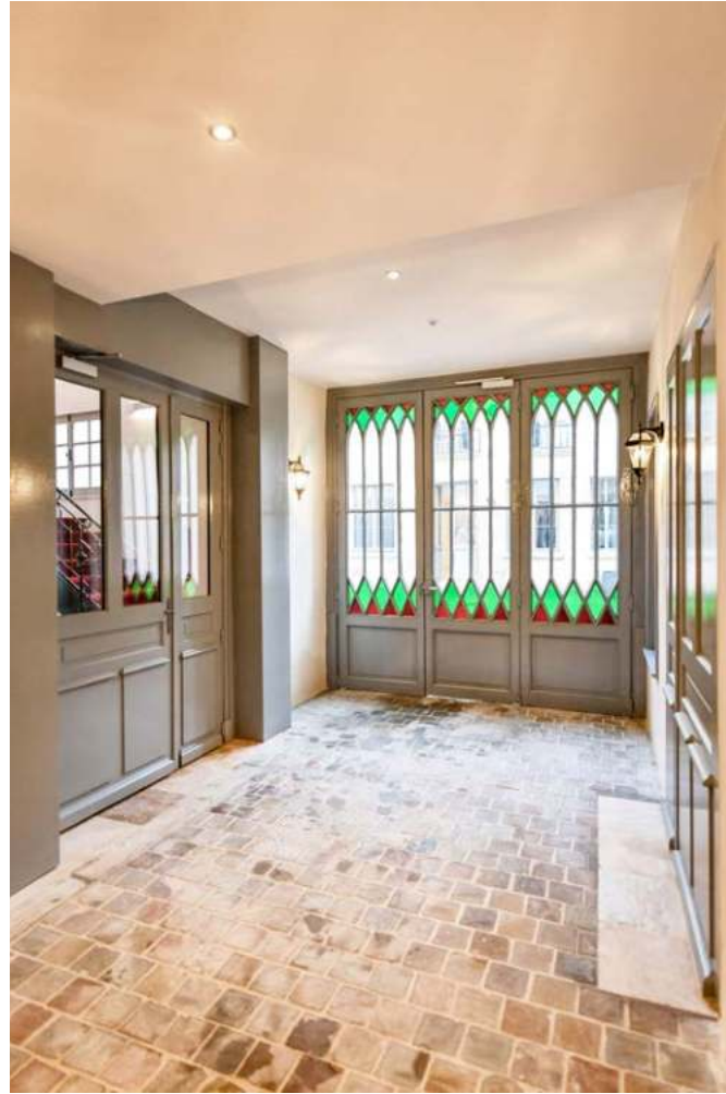
Restauration des espaces communs. Dallage en pierre d'origine restauré et re-jointé.
